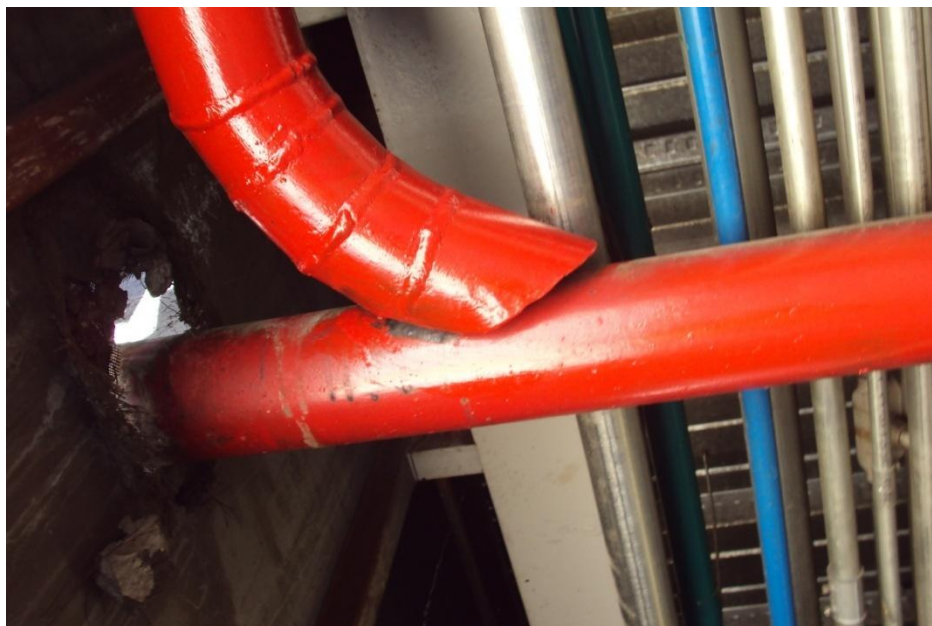
SOLDADO Y LIMPIEZA DE EMPATE DE RED PRINCIPAL CONTRA INCENDIO CON E-60-10 Y E-70-18 EN AEROPUERTO INTERNACIONAL BENITO JUAREZ
