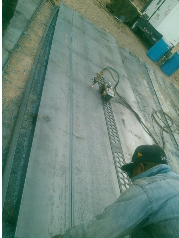
ARMADO DE COLUMNAS TIPO CAJON A BASE DE PLACA DE ½"
