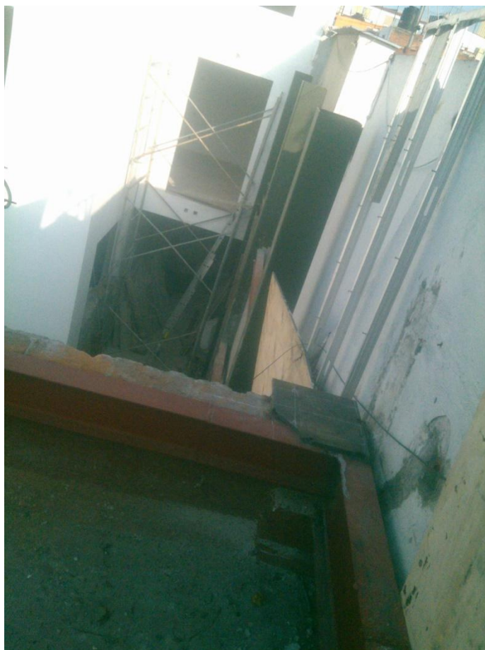
Montaje de columnas a base de hss de 8" x 8" x ¼"
