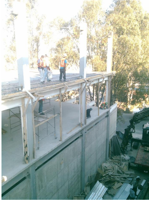
MONTAJE DE CERRAMIENTO PARA TECHUMBRE A BACE DE IPR DE DIFERENTES PERANTES
