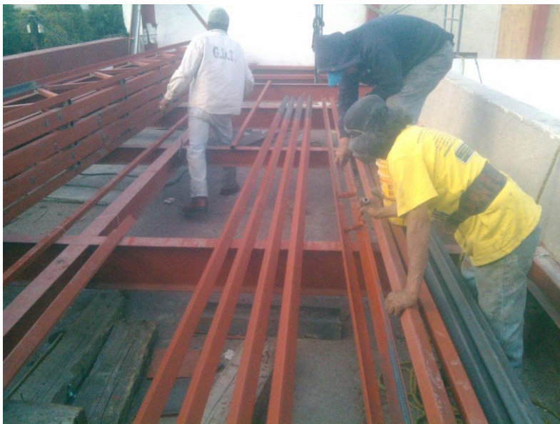
FABRICACION DE JOIST PARA CERRAMIENTO EN TECHUMBRE A BASE DE ANGULO DE 2" X ¼ Y OR DE 2" X ¼" DE ESPESOR
