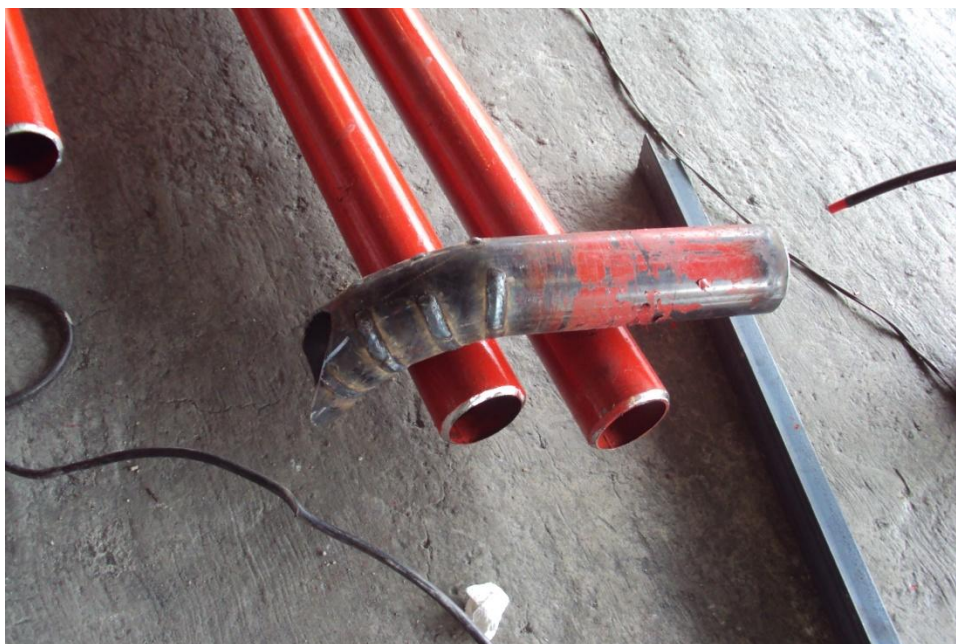
FABRICACION Y SOLDADO DE CONEXIONES TIPO "Y" PARA SISTEMA DE RED CONTRA INCENDIO EN DIFERENTES POSICIONES EN AREA DE SALAS
