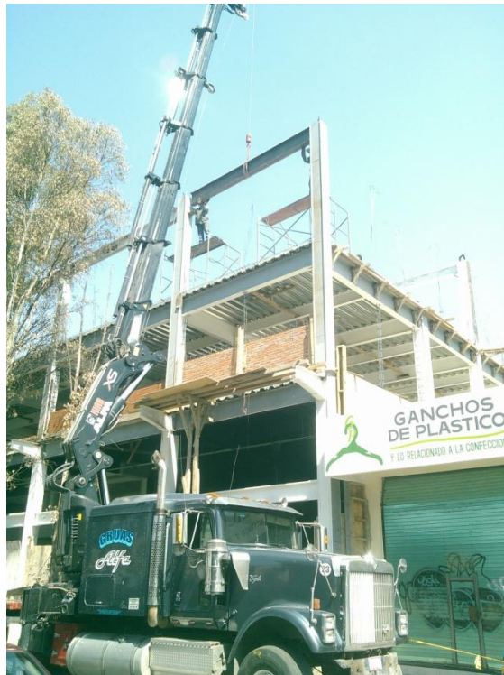
MONTAJE DE CERRAMIENTO PARA TECHUMBRE A BACE DE IPR DE DIFERENTES PERANTES
