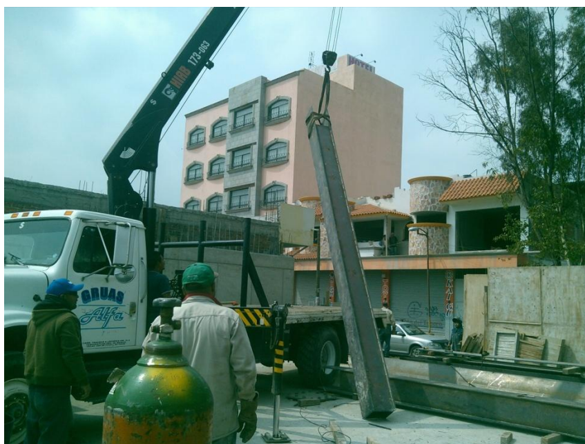
MONTAJE DE COLUMNA A BASE DE 4 PLACAS CON UN ESPESOR DE \frac{3}{4} " PARA PRIMER NIVEL
