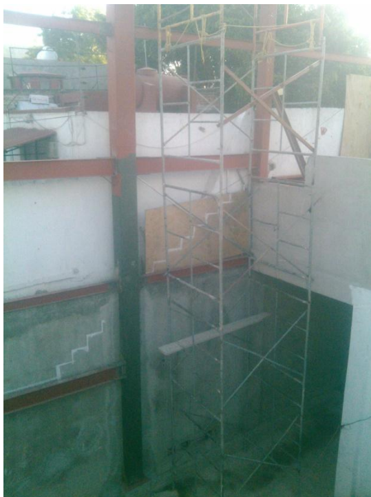
Montaje de columnas y cerramientos para soporte de estructura de techumbre
