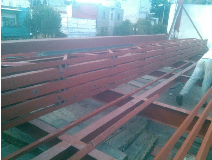
MONTAJE DE JOIST EN AREA DE TERRAZA
