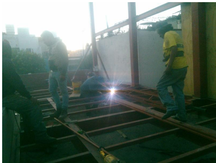
Colocación de placas base para columnas a base de hss de 8 " x 8" x ¼ "
