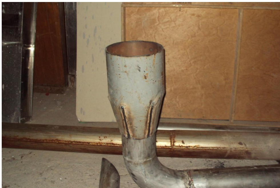
MONTAJE Y ACAVADOS DE TUBERIA PARA CHIMENEAS DE GASES DE ESCAPE DE GENERADORES ELECTRICOS EN AEROPUERTO INTERNACIONAL BENITO JUAREZ
