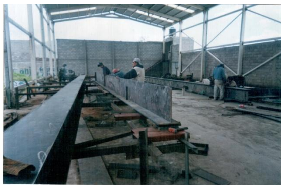
Fabricación De Estructura Metálica En Tres Placas Ubicación Cafetales México. D.F. Obras Oficina De IFE.
